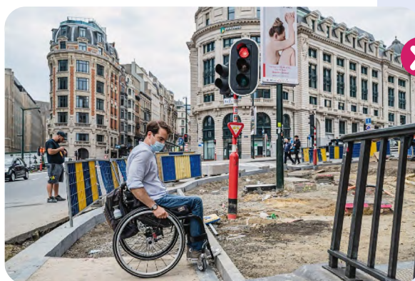
Cheminement piéton sur sol meuble avec des bordures, obstacles, etc.
