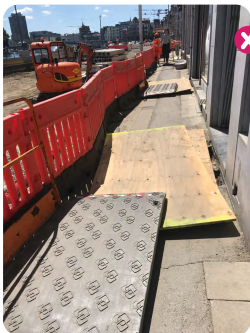
Panneaux et plaques inadaptés qui représentent des obstacles dans le couloir de contournement.
