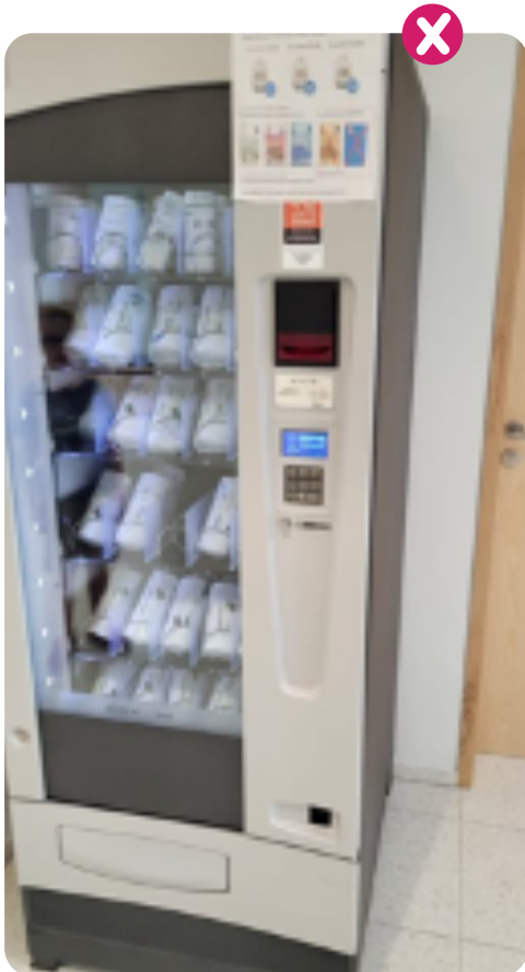
Absence d'identification sur les côtés latéraux
